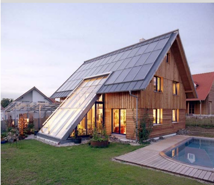
Foto: Bausparkasse Schwäbisch Hall / Lorenz-Behälterbau
